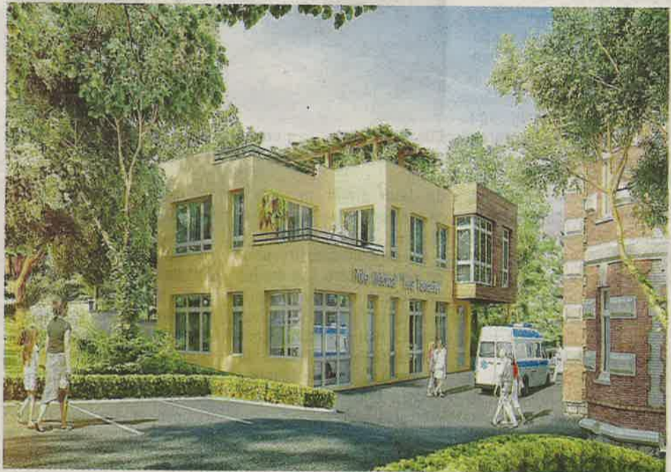
Le pôle médical « Les Tamaris ». Le bâtiment neuf construit à l'arrière de la villa complètera l'espace soins.
